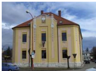
Budova Univerzity Konštantína Filozofa v Spišskej Novej Vsi.
